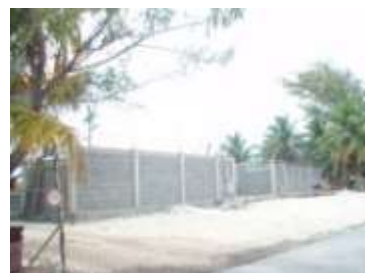
現在建設中の空港
